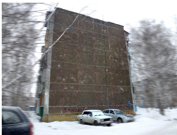
Рис. 6. Дом по улице Мичурина 61, видовая точка 5
