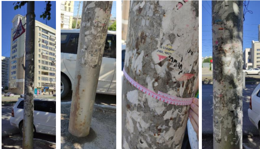
Рисунок 1 – Этапы проведения обследования опоры контактной сети
